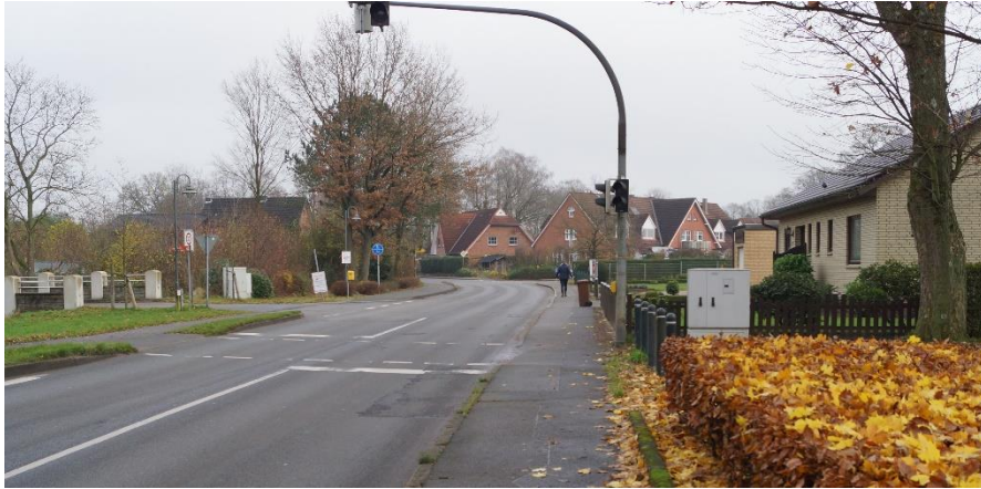
Abbildung 30: Bedarfsampel an der Kaltenkirchener Straße (L 80) 32
