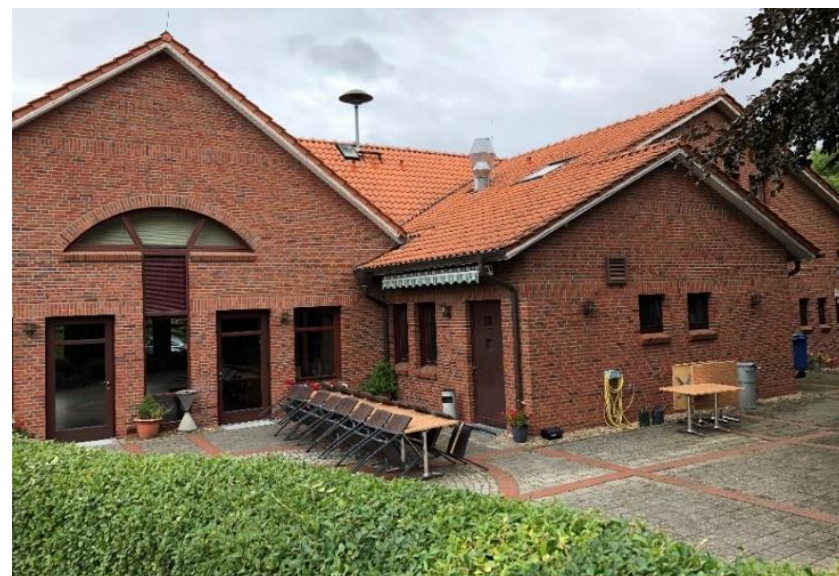
Abbildung 20: Außenbereich des Gemeindehauses 20
